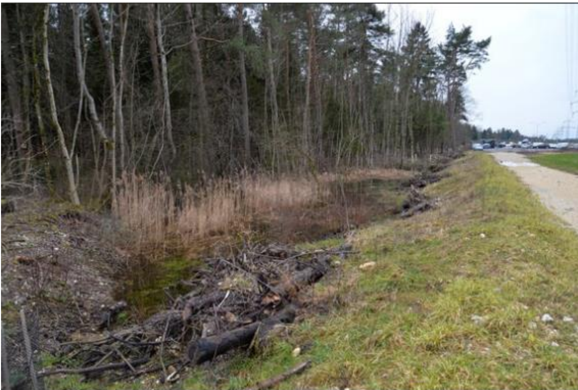
Verstärkter Damm südlich Industriegebiet Studen © Oliver Menge
