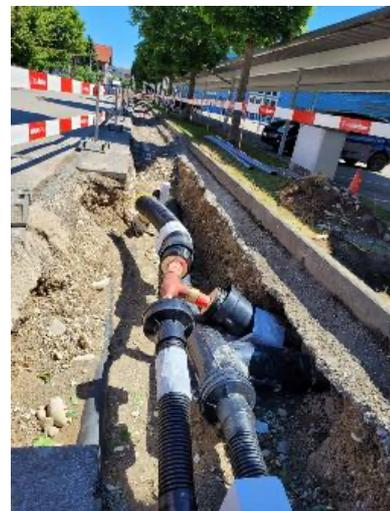
Abbildung 10: Rohrleitung mit T-Stück für Anschluss Landi in der Schulriederstrasse
