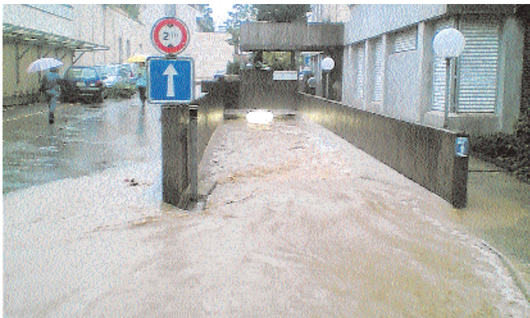
Mehr Wasser geht nun wirklich nicht mehr hinein in die Einstellhalle am Lysser Marktplatz zwischen Coop und UBS.
